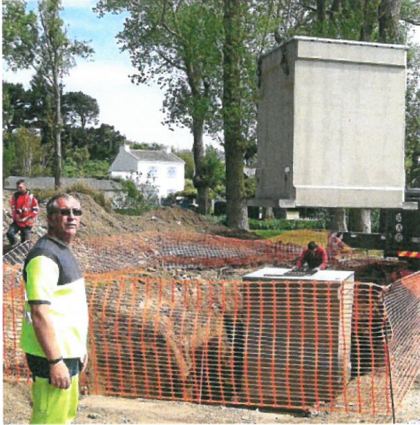
Thierry Guiton, chargé de la gestion des déchets de Groix, assiste à la mise en place des colonnes en béton sur le point de collecte de Pokado.
